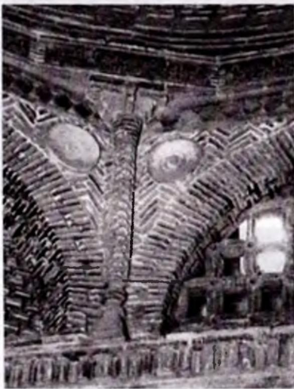
*10.14-rasm. Ismoil Somoniy maqbarasining arkalar oralig'idagi bezakdor g'ishtli konstruksiyasi (sakkiz arkali konstruksiyasining elementlari)*
