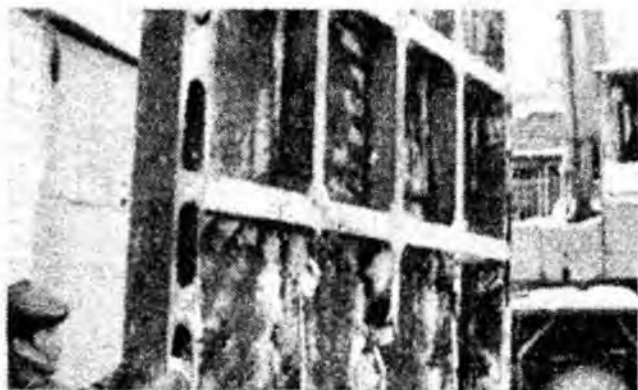
5.4 - расм. Дўстлик канални ПК 260 ва ПК 580 да жойлашган гидроузелларга ўрнатилган затворларда юз берган каррозия ходисаси
