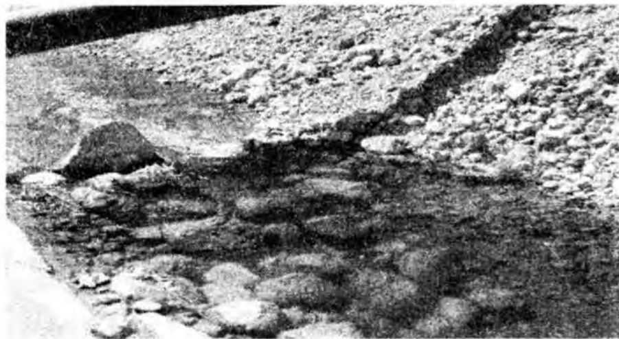
5.19 – расм. Тоғ ён-бағридан ўтган канал ўзанини тош босиши ҳолати.
