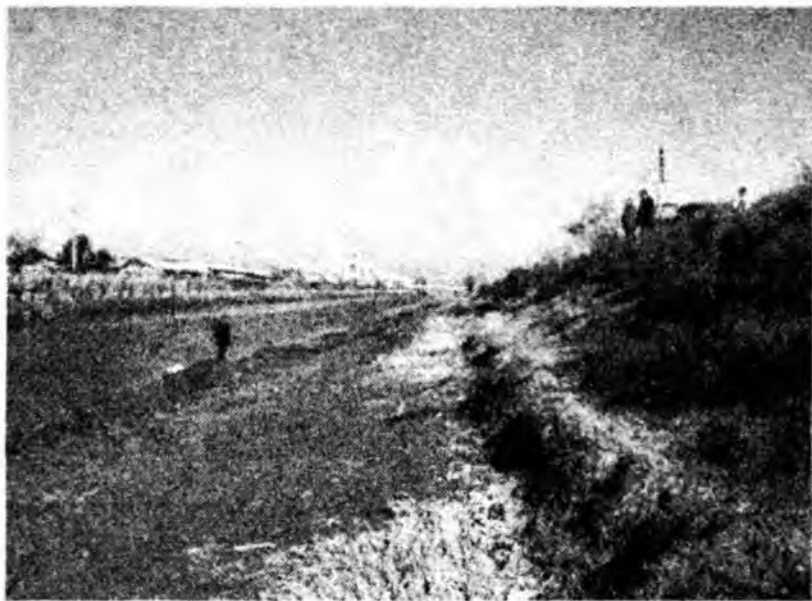
5.18 - расм. Дўстлик каналининг кабарик қисмидаги лойқа чўкиш ҳолати
