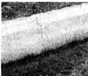
1.10 - расм. Стандарт параболик нов.
