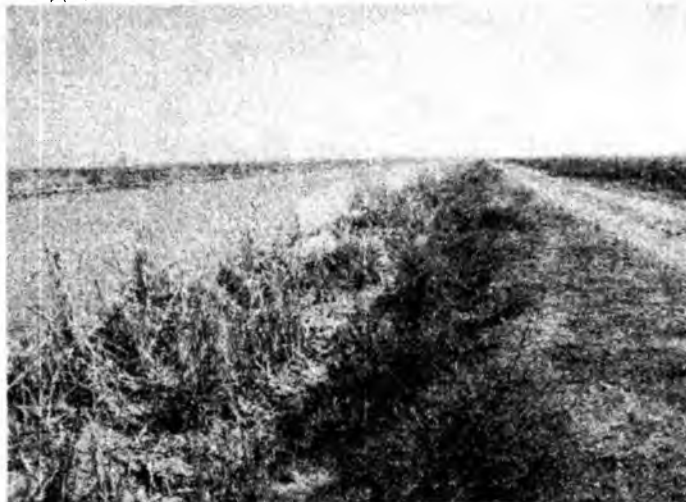
5.9 - расм. Канал қирғоғини ўт босиш ҳолати
