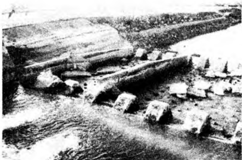
5.2 - расм. Дўстлик каналининг ПК 580 да жойлашган ташлама иншоотни пастки бьефидаги абразив емирилишлар
