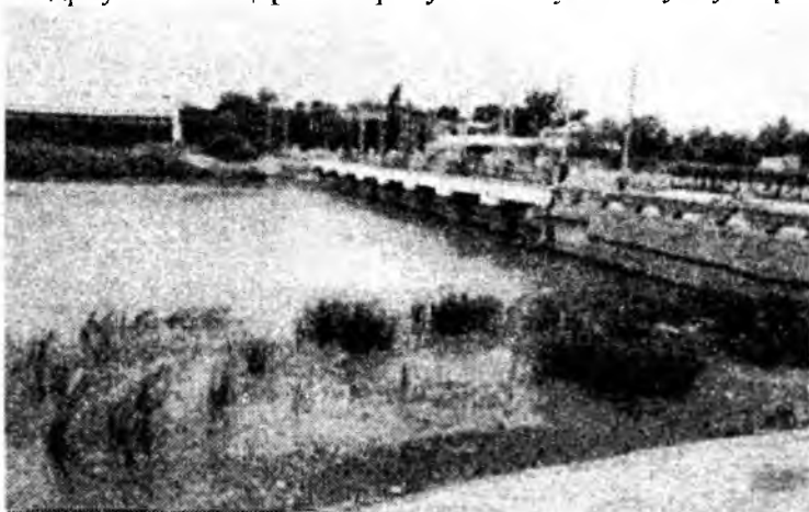
5.12 - расм. Жанубий Мирзачўл каналининг ПК 145 даги гидроузелни юқори бьефи ўзанида ўсган сув ўтлари
