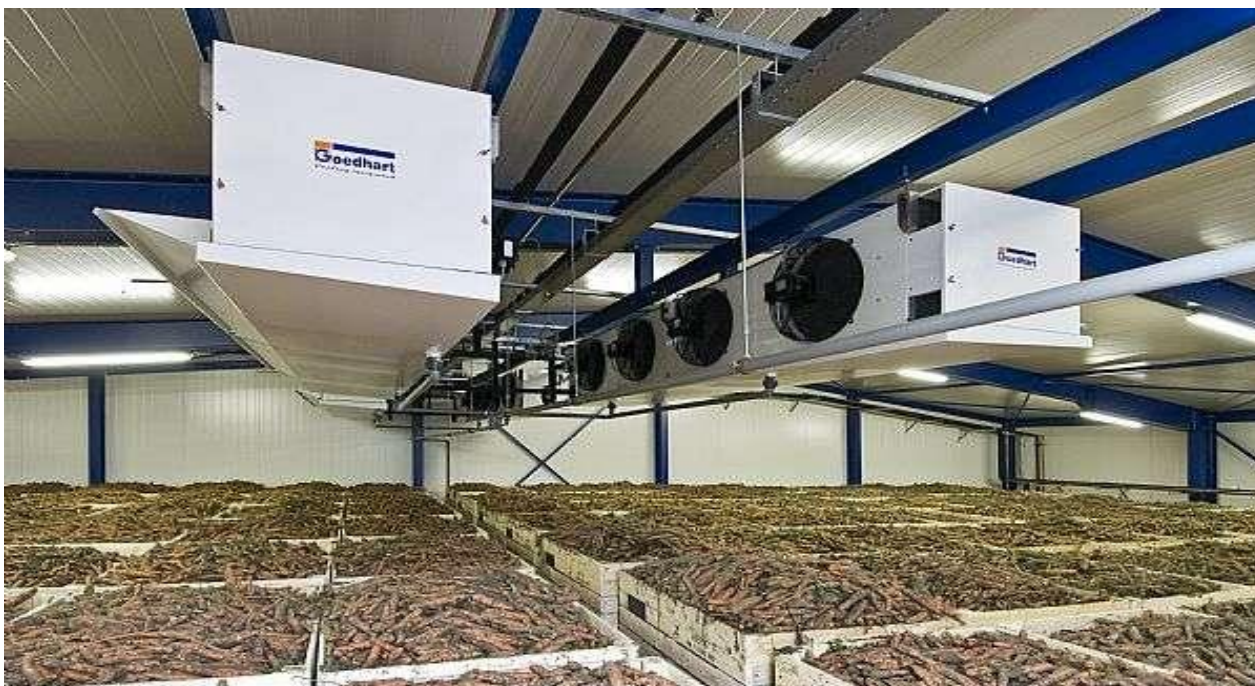
1-rasm. Zamonaviy tipdagi sovutish va shamollatish tizimlari bilan jihozlangan meva-sabzavot omborining ichki ko'rinishi.
